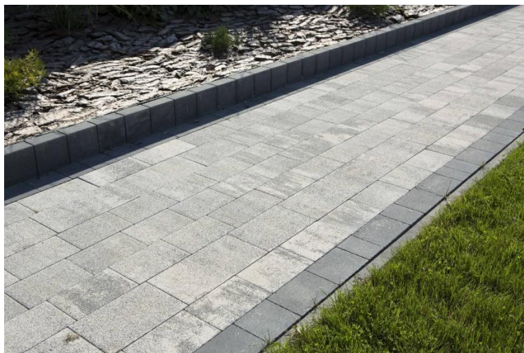
Utwardzenie z płyt chodnikowych granitowych, płomieniowanych, gr. 8 cm – pogładowe zdjęcie
