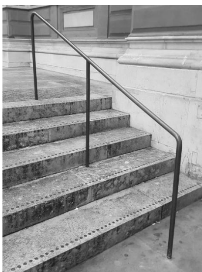
Przykładowa balustrada montowana przy schodach – wysokość 1,1 m, min. 30 cm przed i za schodami, profil okrągły, ze stali nierdzewnej
